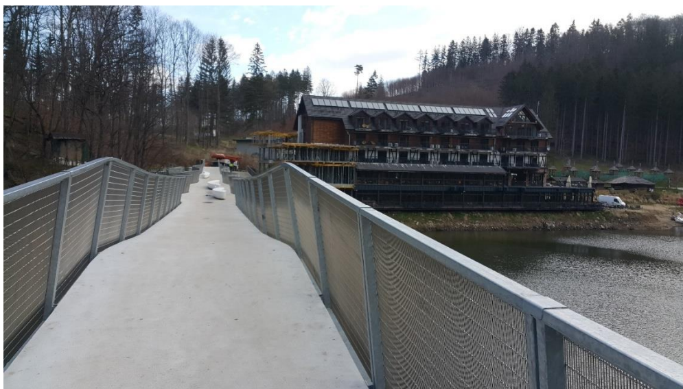
Nowa kładka nad Jeziorem Bystrzyckim
