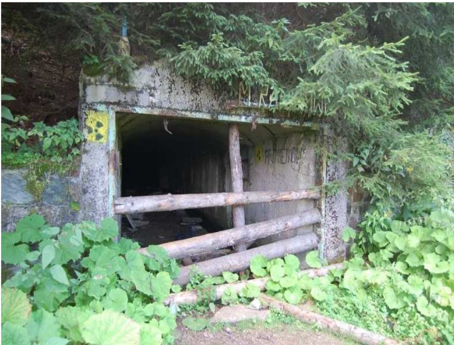
112_1 Wejście do starego inhalatorium radonowego
